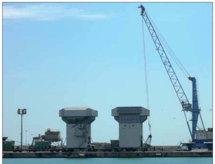
Las nuevas tolvas están ubicadas en los muelles 6 y 7.
